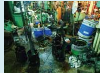
各機器・配管の整備
