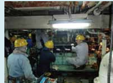
主機関・発電機開放整備
